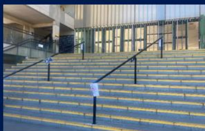
Baranda en escalera gimnasio
